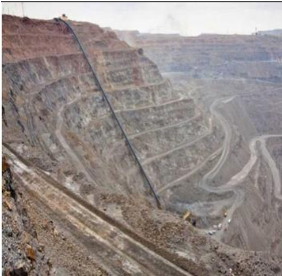
Hình 1. Tổ hợp nghiền và băng tải dốc KNK-270 tại mỏ Muruntau - Uzbekistan
